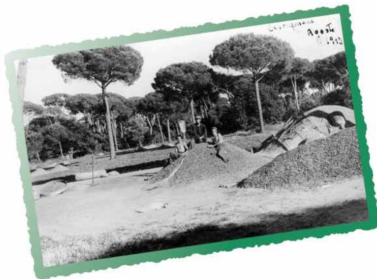
Pinottolai al lavoro. Castelfusano, Agosto 1943
