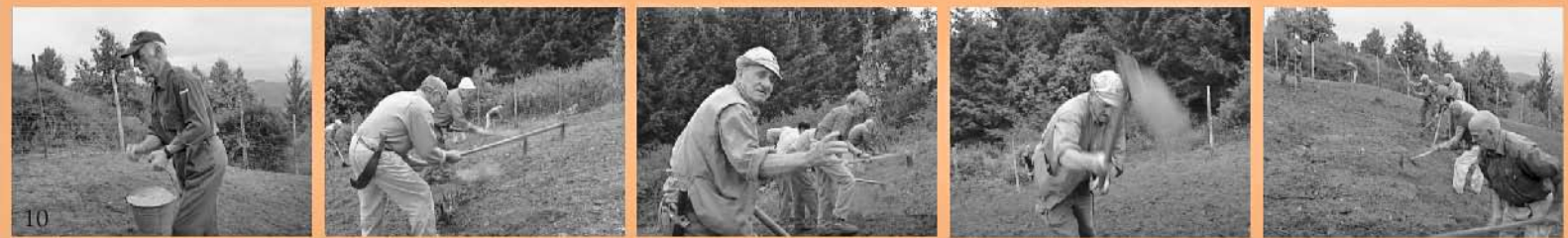
Cantiere per la costruzione della strada di Carda
